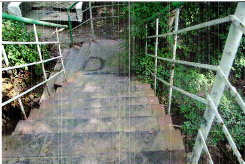
Фото 3. Лестница переходного моста
